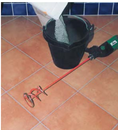
Mezclar con batidor eléctrico.
